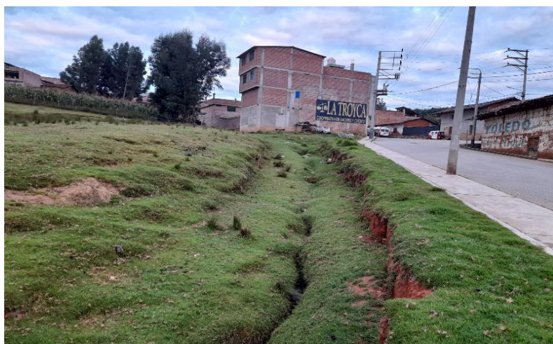
IMAGEN N°01: Se observa la quebrada 9 de octubre requiere de mantenimiento de cauce de corte de caja hidráulica
