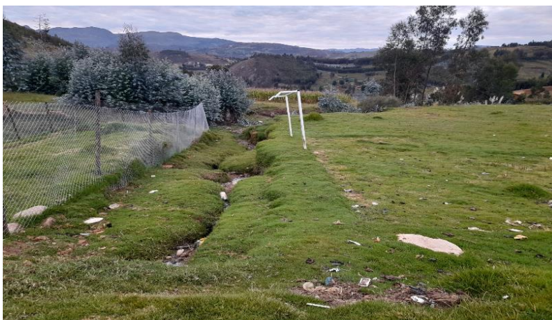
IMAGEN N°02: la quebrada 9 de octubre requiere de encauzamiento con el corte de terreno natural de 0.80 m aproximadamente
